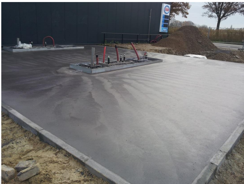
Foto: Aanleg van vloeistofdichte betonvloer.
