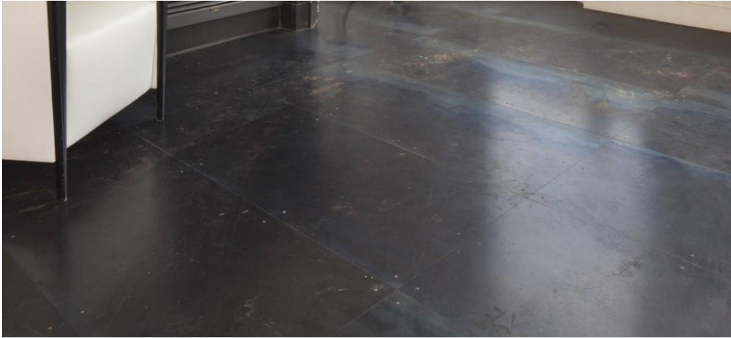
Foto: Voorziening van aan elkaar gelaste metaalplaten.
