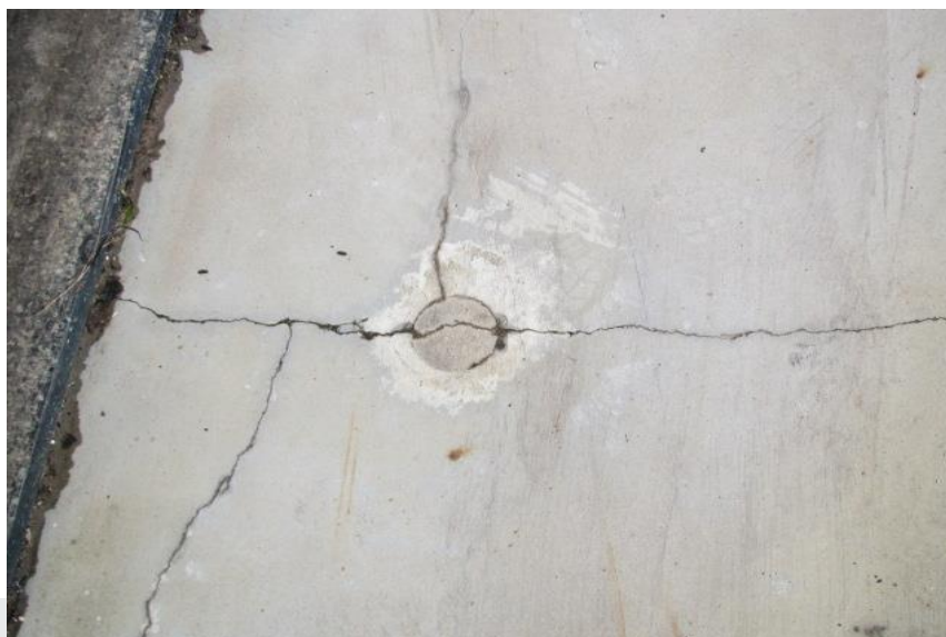
Foto: Voorbeeld van scheur.
