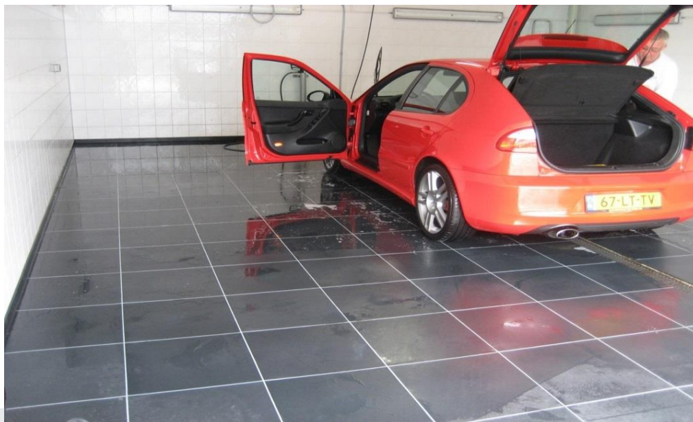
Foto: Vloer uitgevoerd met kunststof elementen.
