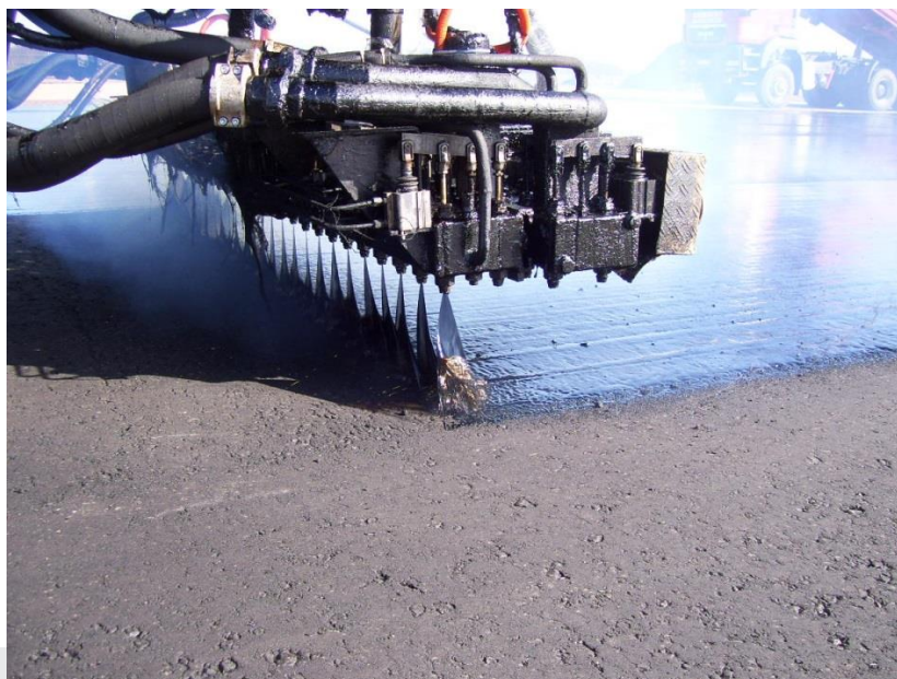
Foto: Aanleg vloeistofdichte asfaltconstructie.
